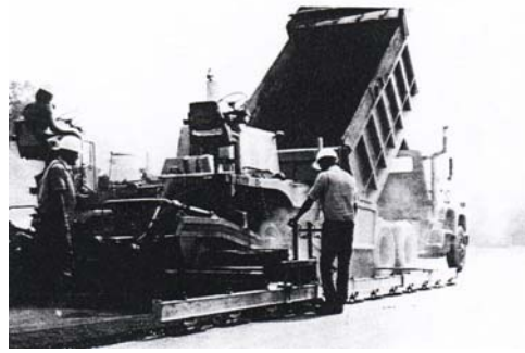
圖 5 鋪築瀝青路面
