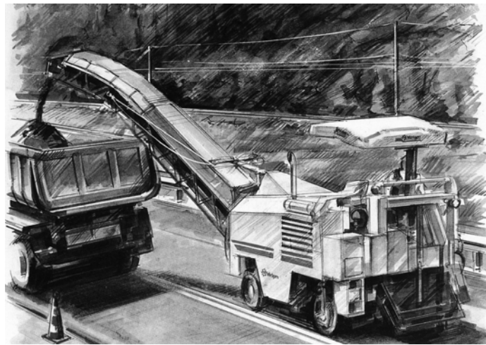
圖 1 損壞舊瀝青路面刨除施工
