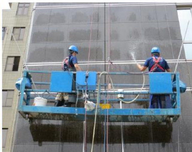
使用吊籠或繩索作業於10層樓或樓高30公尺以上建築物外牆作業
