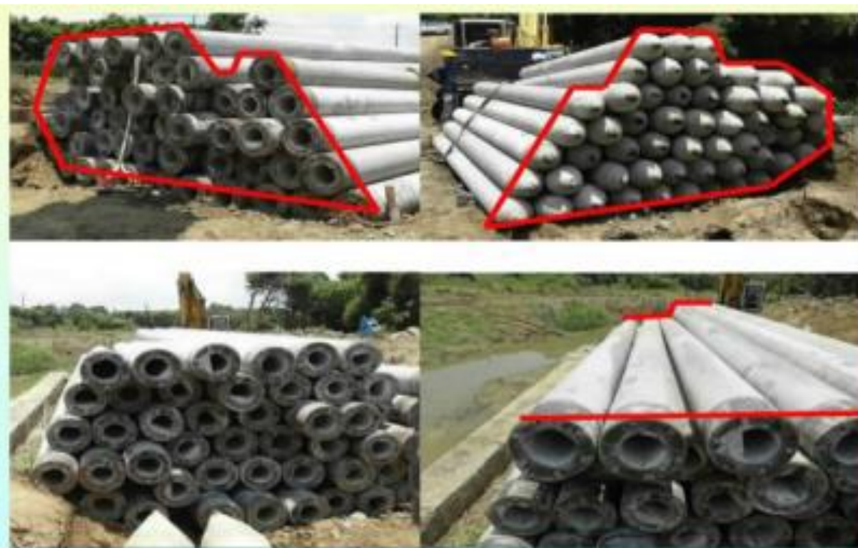
由堆疊之基樁樁帽端及樁頭尖端非對應 式之排列方式，顯示基樁並非整齊堆疊
