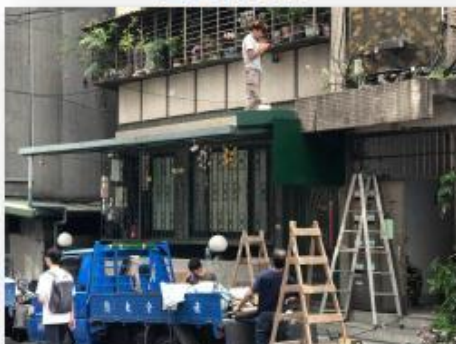
雨遮拆除作業
