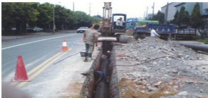
埋管工程未設擋土設施，結果造成土壤崩塌掩沒勞工之災害
