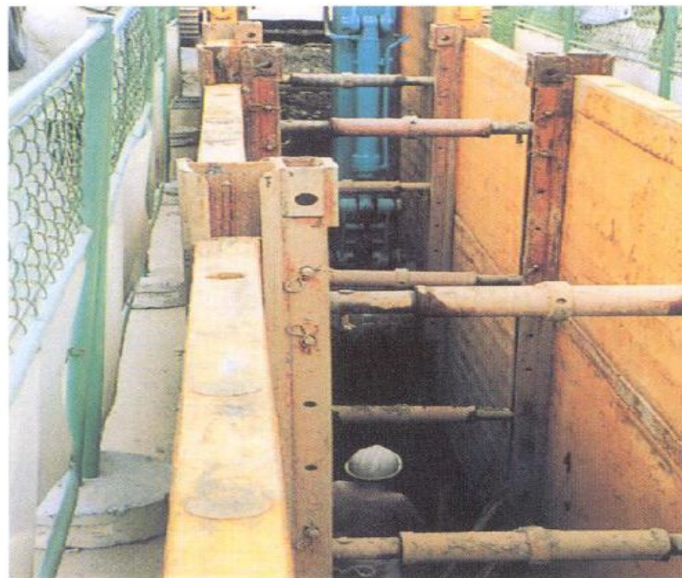
挖溝作業使用擋土支架，並設檔板以防土石崩落
