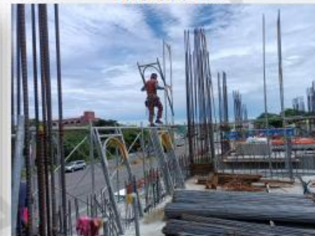
施工架組配作業
