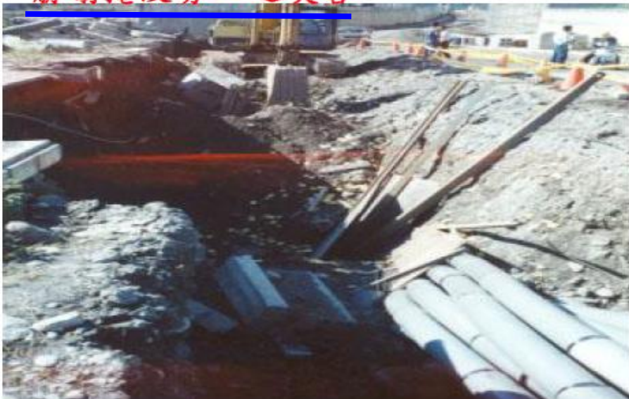
埋管工程未設擋土設施，結果造成土壤崩塌掩沒勞工之災害
