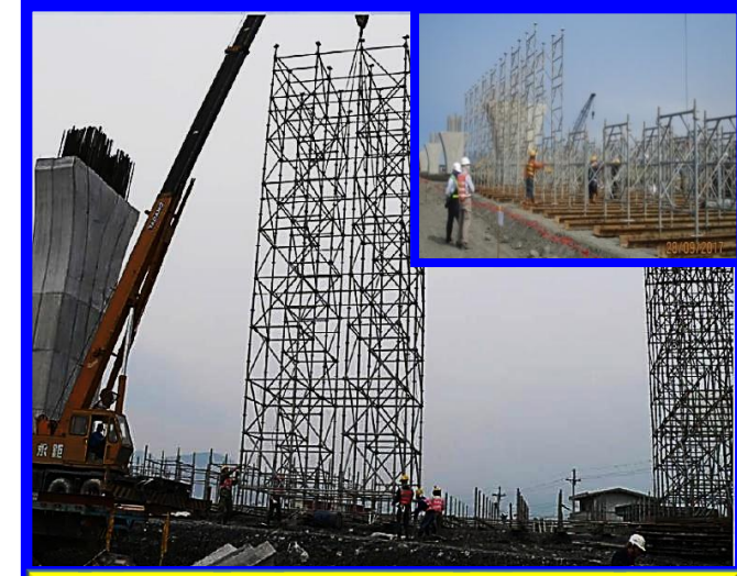
支撐架地面組立完成後吊裝
