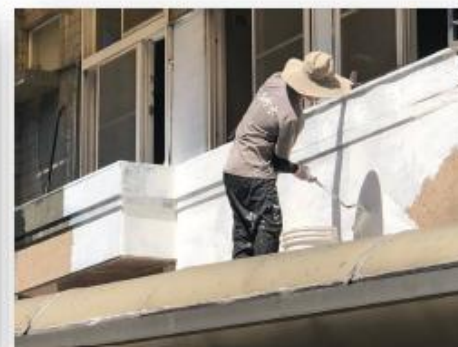
外牆裝修作業
