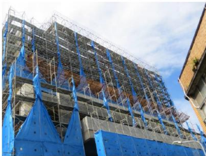
高度達7層樓或20公尺以上之施工架組拆作業
