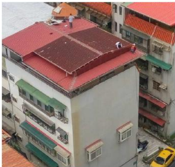
4層樓或樓高12公尺以上建築物之輕質屋頂施工作業
